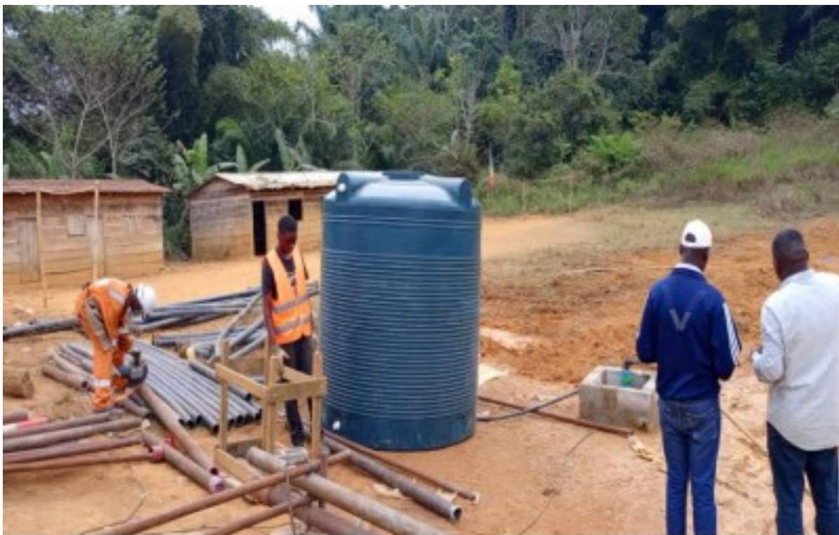
Construction d'un forage d'eau au village Bada par Périmont
