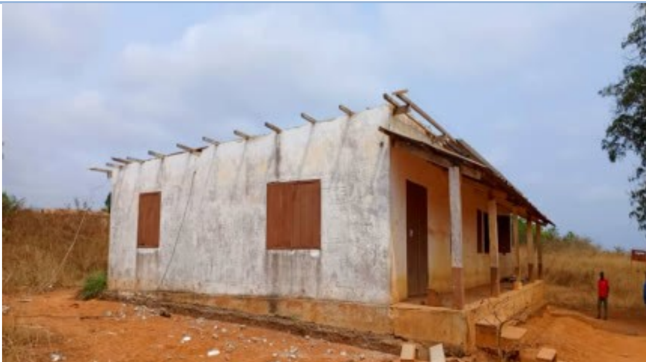
Projet de réhabilitation du Centre de santé intégré de Bivela non achevé
