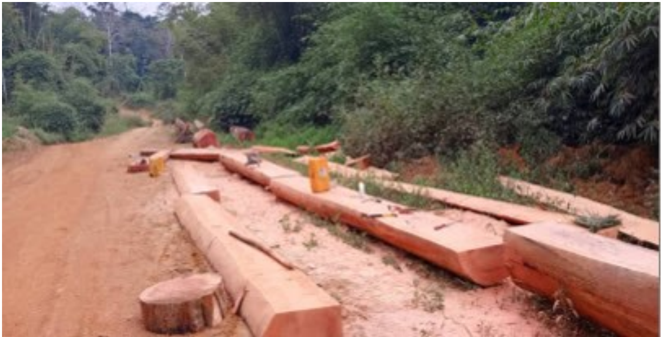
Construction du pont sur la rivière Matandala reliant Bada à Kakamoeka centre par la société Perimont
