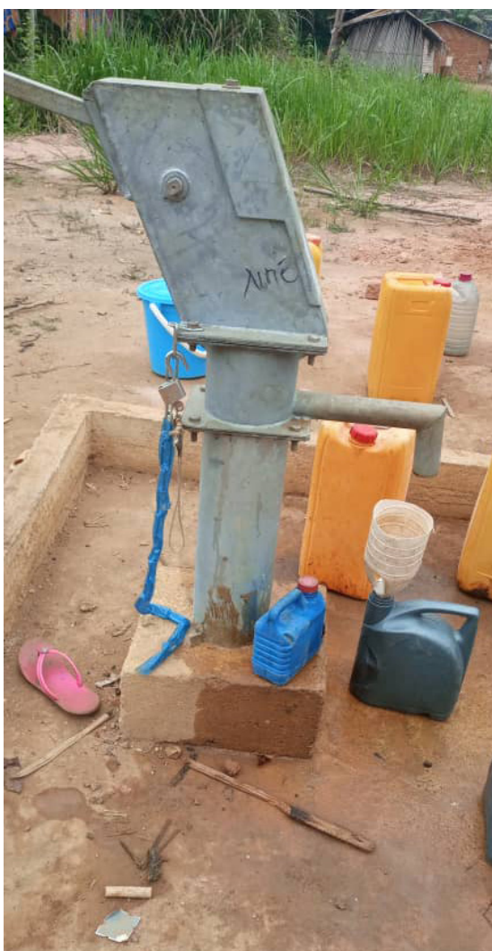
Installation d'un forage d'eau au niveau du village Mbaya dans le district de Komono dans le cadre du FDL
