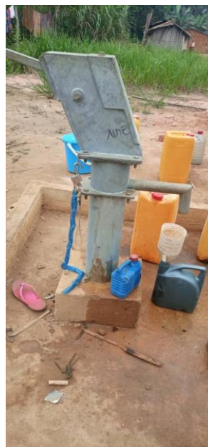
Forage d'eau au niveau du village Mbaya
